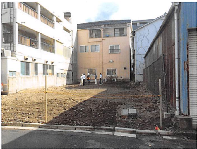
2020/09/18 解体工事の完了 土地所有者が確認
