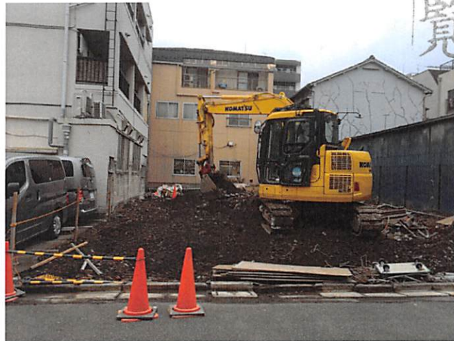
2020/09/16 旧町会会館の解体工事が進行中
